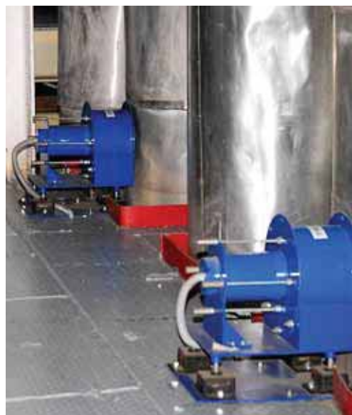
Рис. 2. Расположение оборудования АСРК-ПГ на энергоблоке № 1 Ростовской АЭС Figure 2. Arrangement ARMS-SG equipment at Rostov NPP Unit 1
