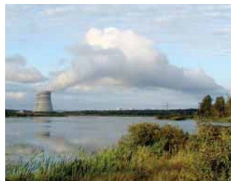
Рис. 3. Выброс водяного пара градирнями Калининской АЭС / Fig. 3. Water vapor emission by the cooling towers of the Kalinin nuclear power plant
