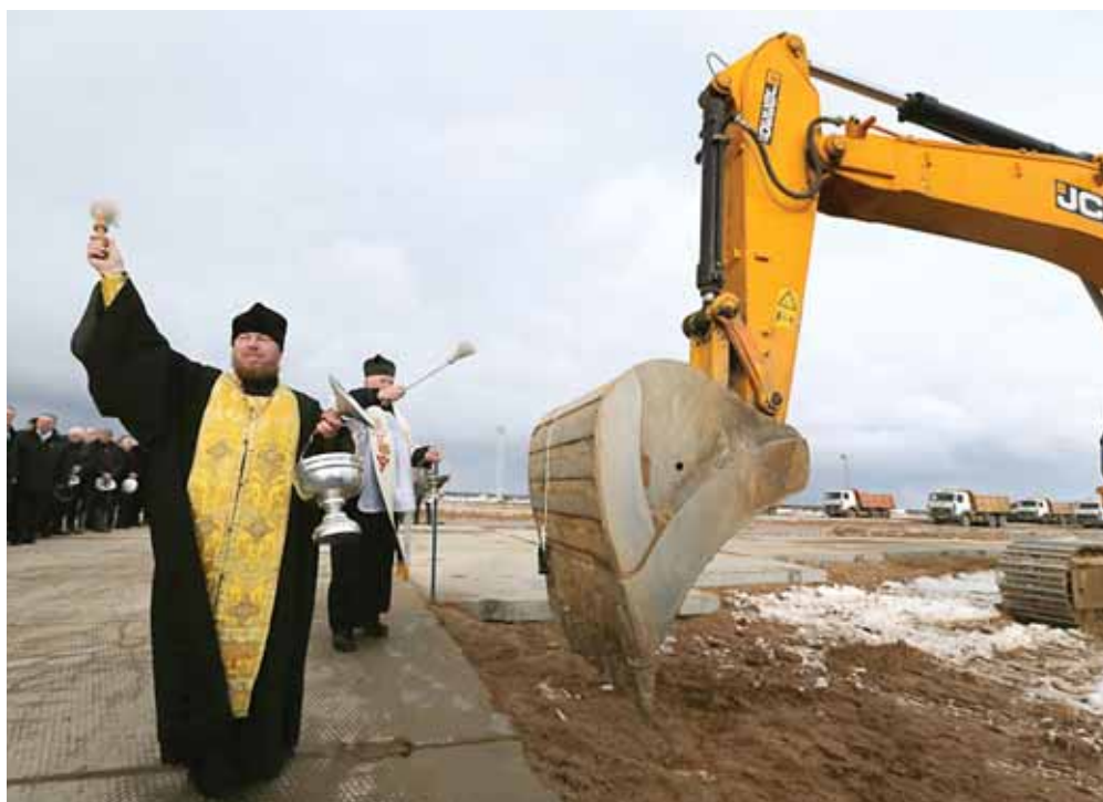
Церемонии по случаю начала подготовки котлована под второй энергоблок началась с освящения (февраль, 2013 г.) / Consecration ceremony dedicated to the commencement of work at the foundation of the 2nd unit (February 2013)
