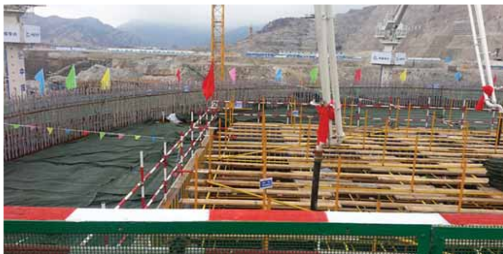
Красочная церемония заливки первого бетона под 3-й энергоблок на ТАЭС
