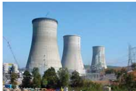
Рис. 5. Сухие градирни Гебзе и Адапазары, Турция. 2310 МВт / Fig. 5. Dry cooling towers in Turkey, 2310 megawatt
