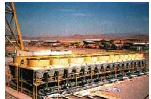
Рис. 10. Вспомогательный охладитель на Шахид Раджай в Иране / Fig. 10. The auxiliary cooler at a power plant in Iran
