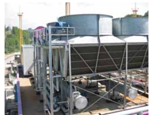
Рис. 10. Вспомогательный охладитель на Сочинской ТЭС 1-2 / Fig. 11. The auxiliary cooler at the Sochi thermal power plant, units 1 and 2
