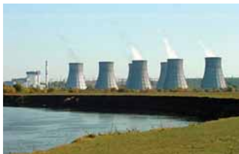
Рис. 1. Испарительные градирни Нововоронежской АЭС / Fig. 1. The wet cooling towers of the Novovoronezh nuclear power plant
