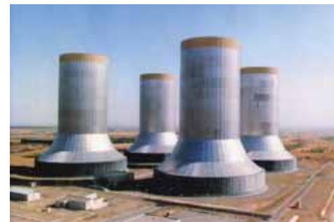
Рис. 6. Сухие градирни Шахид Раджаи, Иран. 750 МВт / Fig. 6. Dry cooling towers in Iran, 750 megawatt
