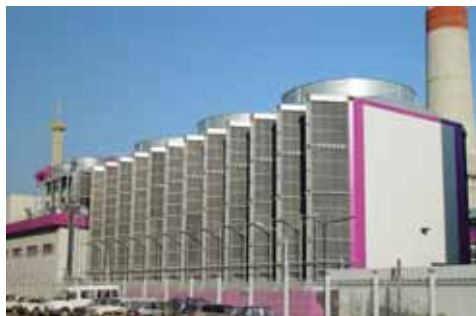
Рис. 4. Сочинская ТЭС, г. Сочи, Краснодарский край / Fig. 4. The Sochi thermal power plant
