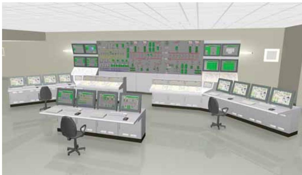
**Рис. 3. Перспективный центральный щит управления АЭС с рабочими станциями основного управления, экраном коллективного пользования и мозаичными пультами резервного контроля и управления (проект) / Fig. 3. Designed central control desk with working stations, remote viewing display and backup control panels**
