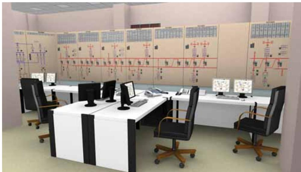
**Рис. 2. ЦЩУ Ростовской АЭС с АРМ основного управления и мозаичным щитом резервного управления (дизайн-проект) / Fig. 2. Central control desk of Rostovskaya NPP with automation-equipped working places and backup control desk (design project)**
