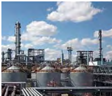
Нефтехимическое производство тоже относится к сложным инженерным сооружениям
