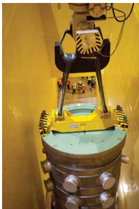
Рис. 8. Установка корпуса реактора ВВЭР-440/В-213 на АЭС «Моховце»/3-й блок
