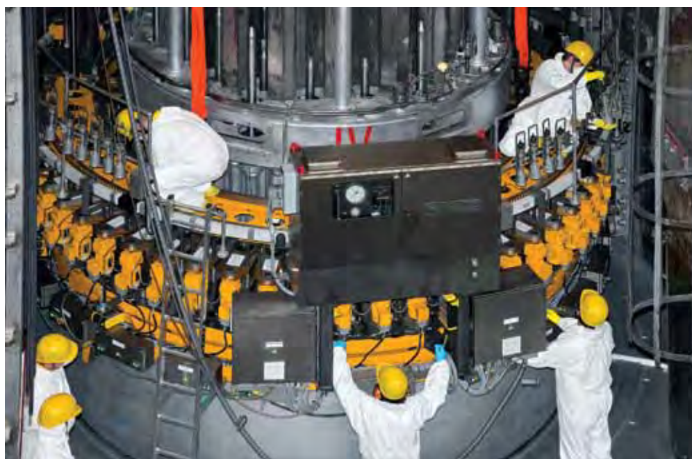
Рис. 9. Эксплуатация гайковерта шпилек главного разъема реактора ВВЭР-1000 на АЭС «Темелин»
