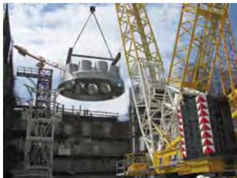
Монтаж корпуса атомного реактора с помощью крана DEMAG
