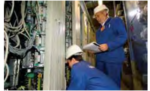
Рис. 5. Модернизация системы контроля и управления на АЭС «Дукованы»
