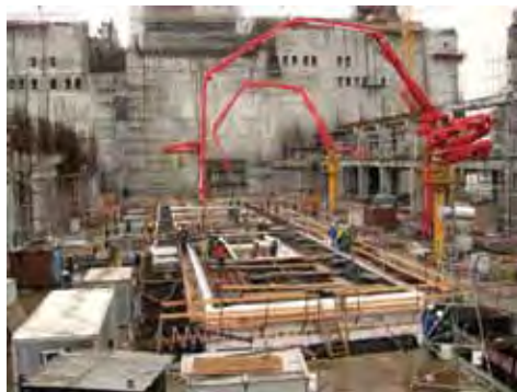
Бетонирование фундамента турбоагрегата
