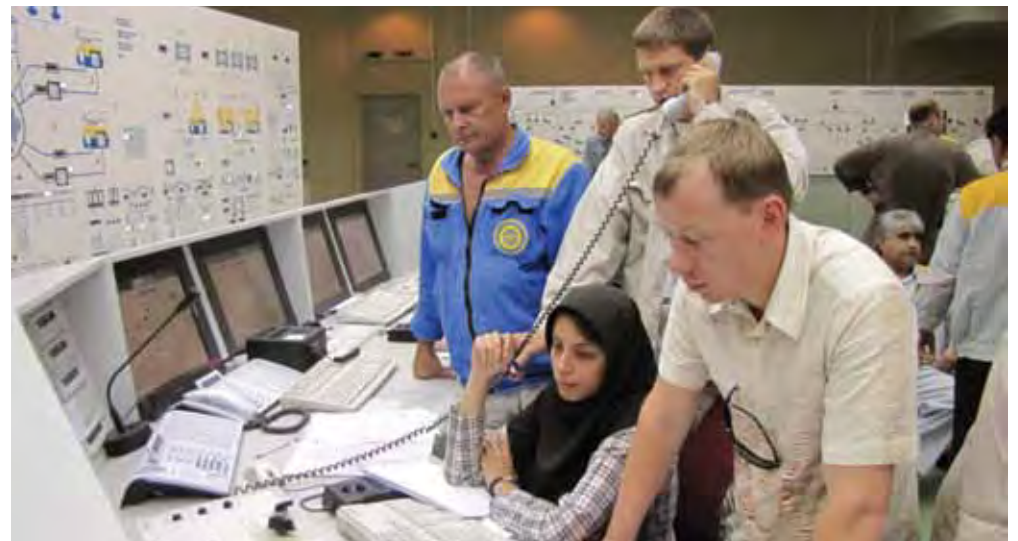
Блочный пункт управления АЭС Бушер (Иран) / Bushehr NPP control room, Iran
