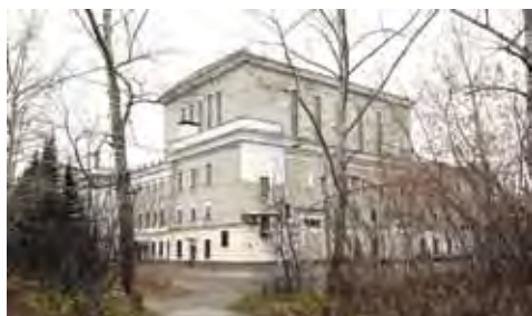
Административное здание СХК Office building SCP
