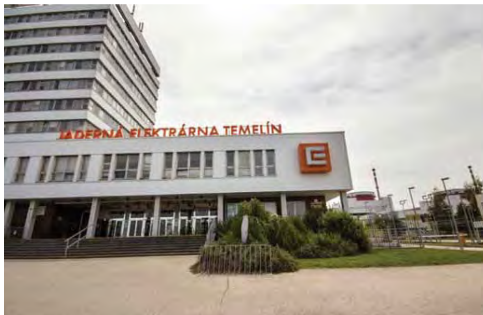
АЭС «Темелин», Чехия / «Temelin» NPP, the Czech Republic
