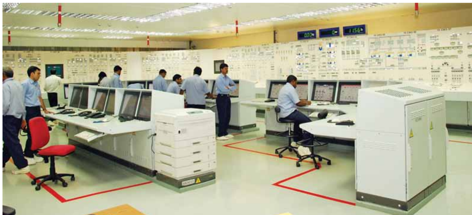
Блочный пункт управления АЭС Куданкулам (ЭБ №1) (Индия) / Kudankulam NPP control room, India
