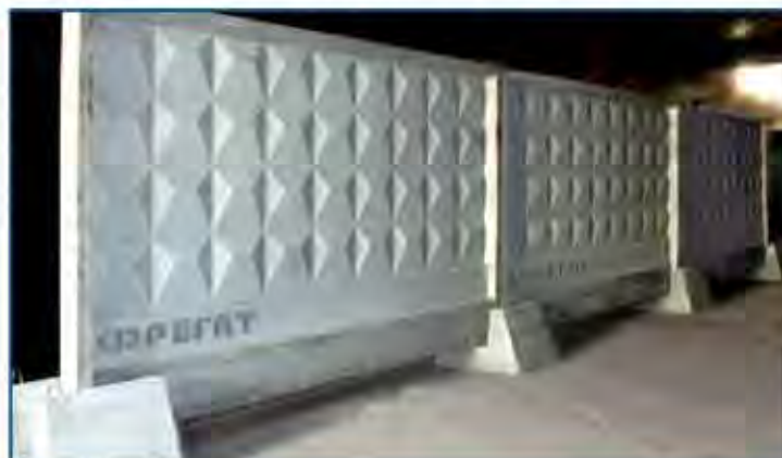
Установка панелей в щелевые стаканы
