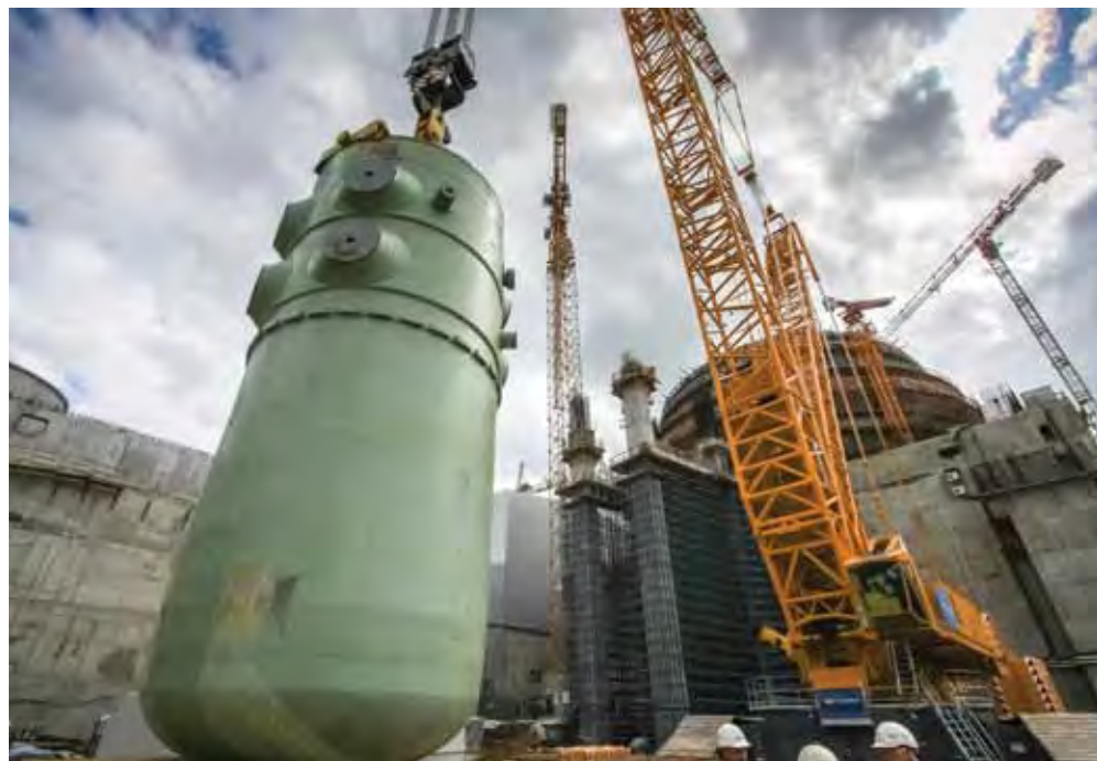
Установка реактора на ЛАЭС-2
