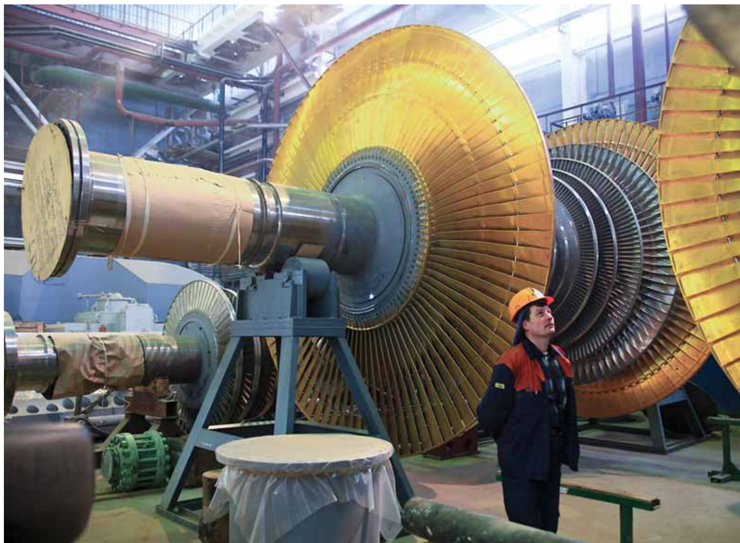
Оборудование Калининской АЭС
