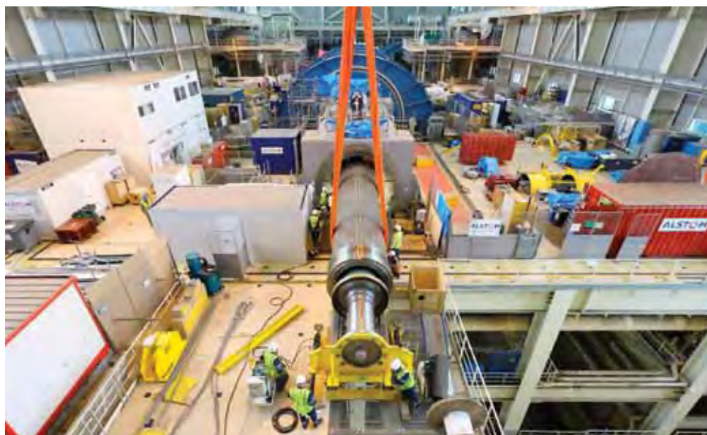
Рис. 4. Установка ротора генератора в статор в помещении машинного зала на 3-м энергоблоке АЭС «Фламанвиль» (фото EDF) / Fig. 4. Generator rotor introduced into the stator at Flamanville 3 site (photo by courtesy of EDF)
