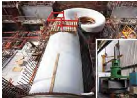
Рис. 5. Монтаж бетонной спиральной камеры на 3-м блоке АЭС «Фламанвиль». Справа внизу: вал насоса и рабочее колесо / Fig. 5. Flamanville 3 concrete volute installation. Bottom right corner: pump shaft and impeller
