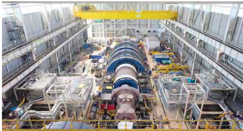
Рис. 2. Монтаж цилиндров низкого давления турбины на Фламанвиль-3 (фото EDF) / Fig. 2: Erection of the Flammanville 3 Low Pressure turbine modules (photo by courtesy of EDF)
