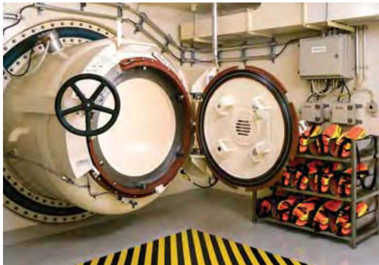
Установка компенсатора уплотнения основного шлюза на атомной станции
