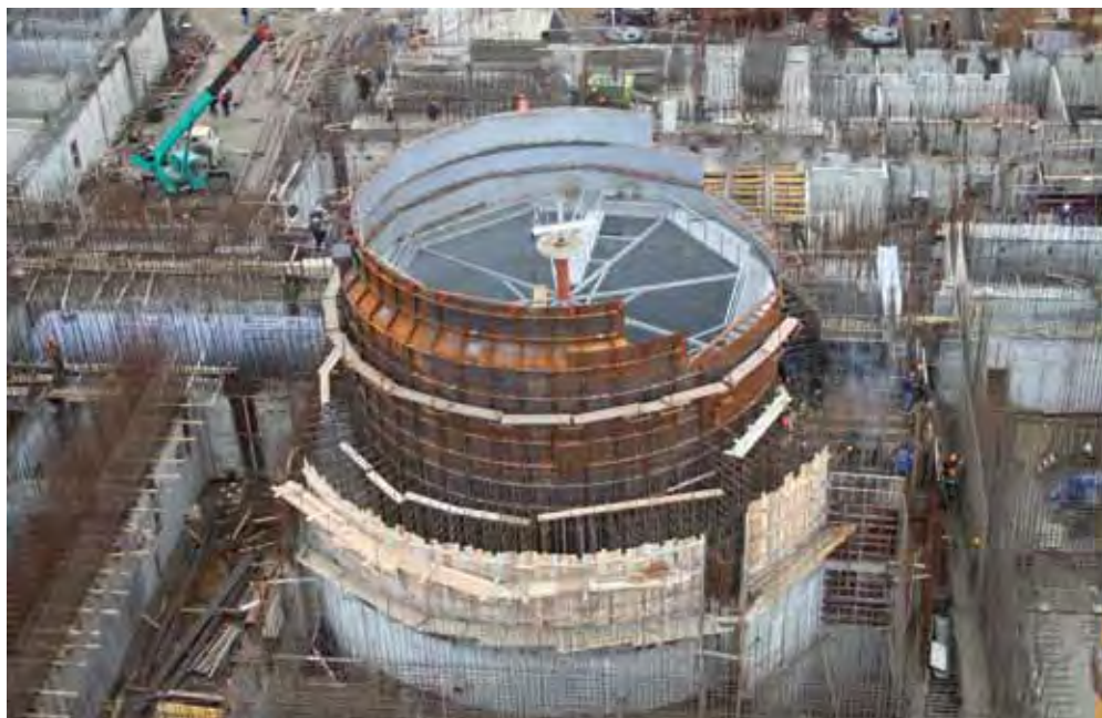
Монтаж шахты реактора БН-800
