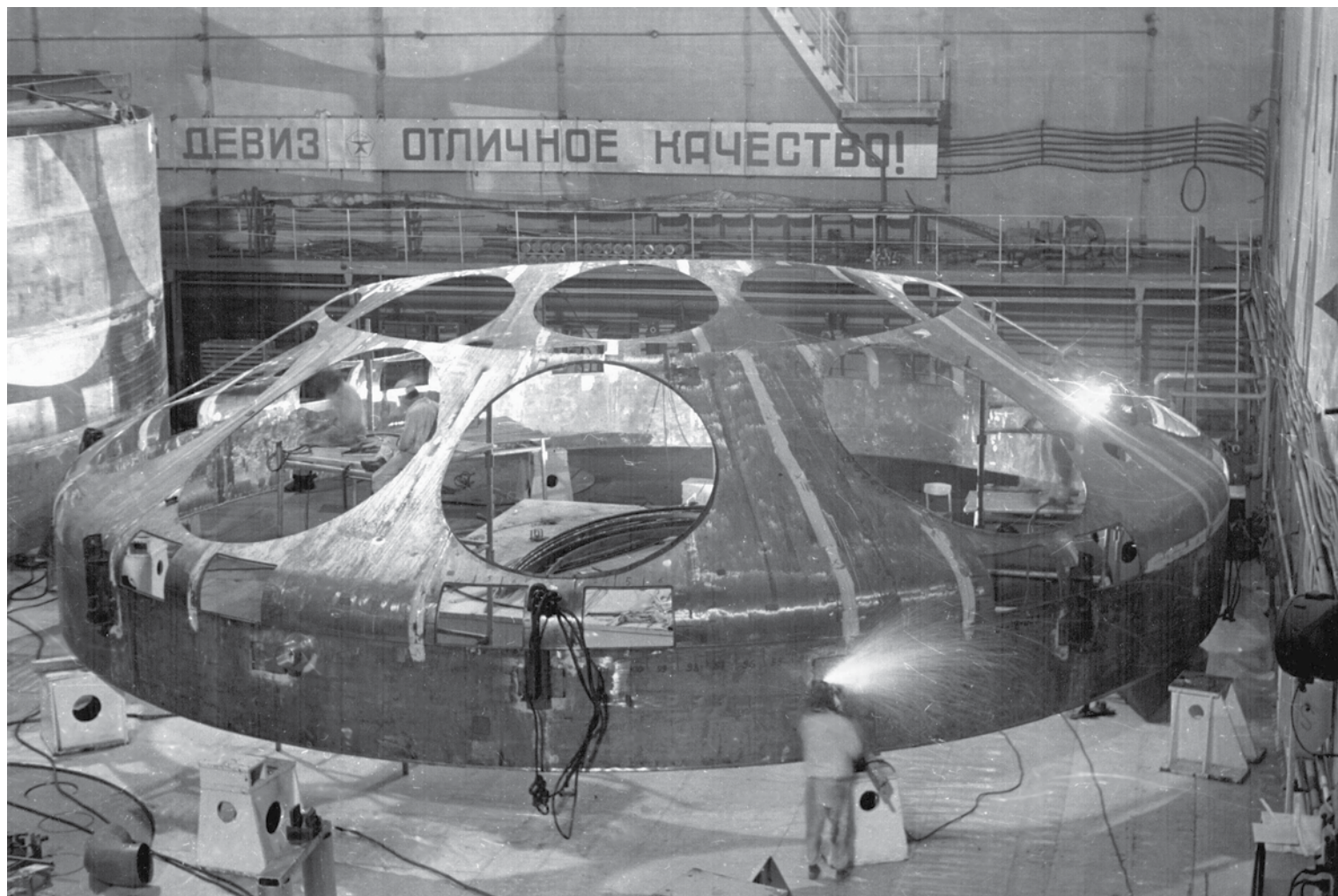
В центральном зале ведется монтаж реактора БН600
