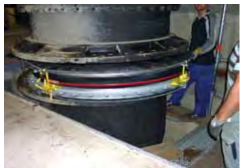
Монтаж резинокордных компенсаторов проводится по разработанным инструкциям
