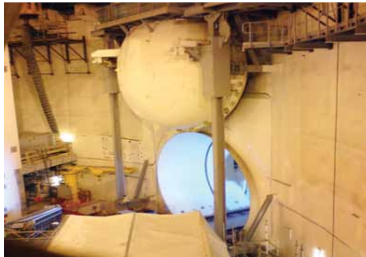
Установка компенсатора уплотнения транспортного шлюза на атомной станции
