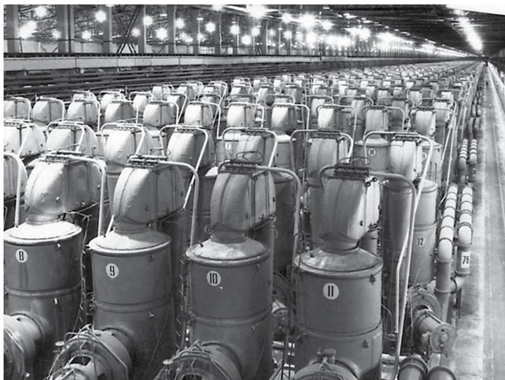
Каскад газодиффузионных машин первого поколения
