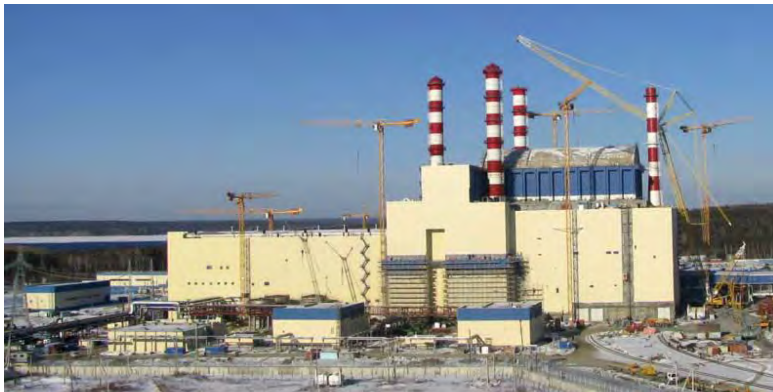
БАЭС, четвертый блок
