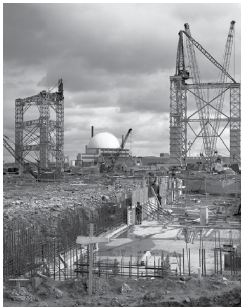
Строительная площадка британского реактора PFR, 1967 год. На заднем фоне – работающий DFR
