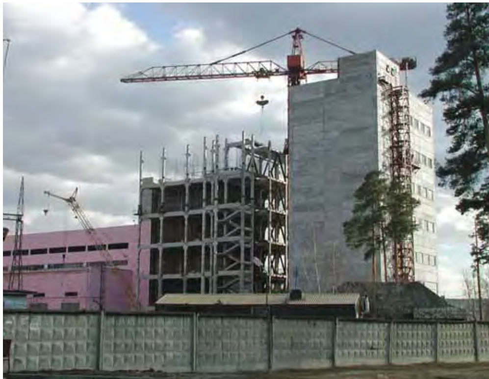
Март 2002 г. Панорама строительства стендов ТКР и ПСБ РБМК «ЭНИЦ»
