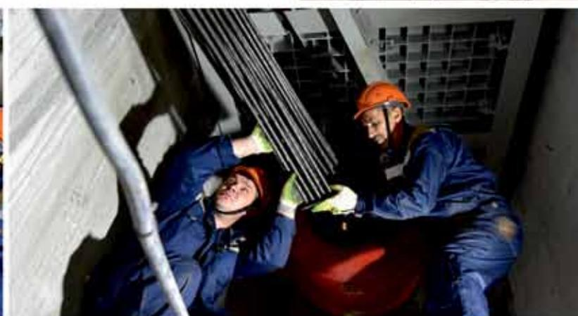
На Нововоронежской АЭС-2 – первой в мире инновационной атомной электростанции поколения «3+» компания ООО «СТС» выполнила поставку и монтаж элементов системы преднапряжения защитной оболочки энергоблоков № 1 и № 2.
