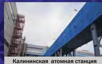
Калининская атомная станция
