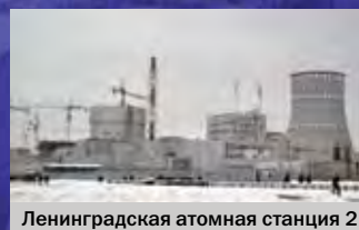
Ленинградская атомная станция 2
