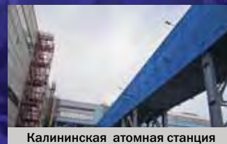
Калининская атомная станция
