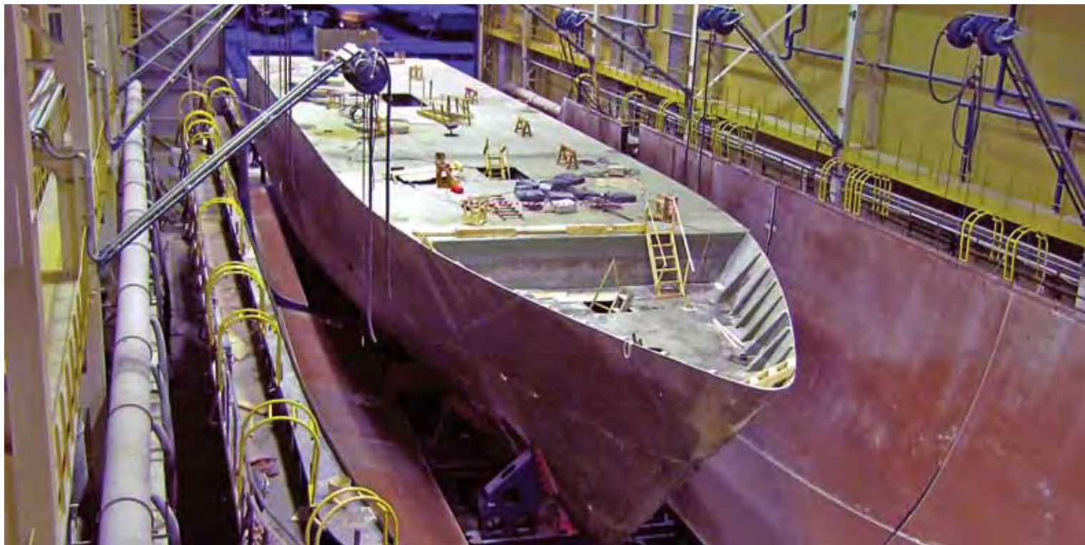
Монолитная обшивка корпуса тральщика из ПКМ на стапеле
