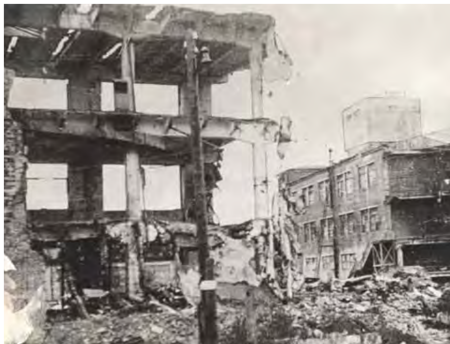
Руины завода после бомбежки 4 ноября 1941 г.
