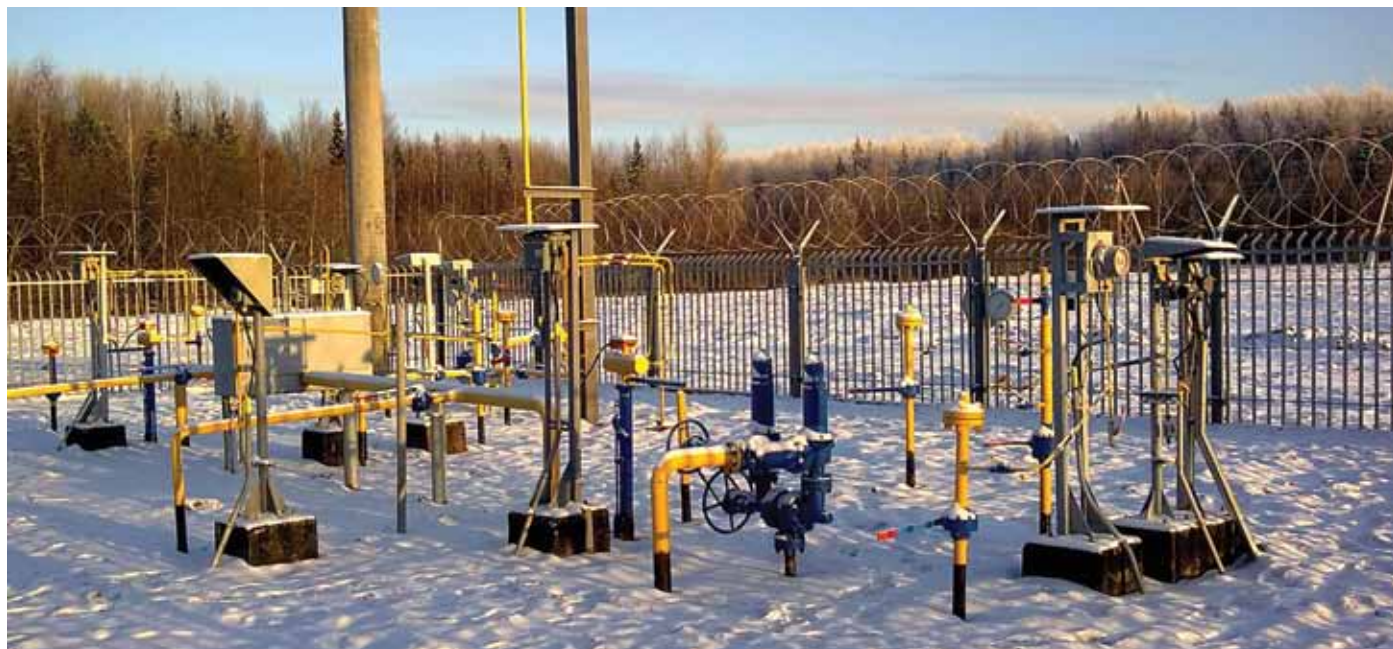
Крановая площадка на одном из линейно-производственных управлений ПАО «Газпром»
