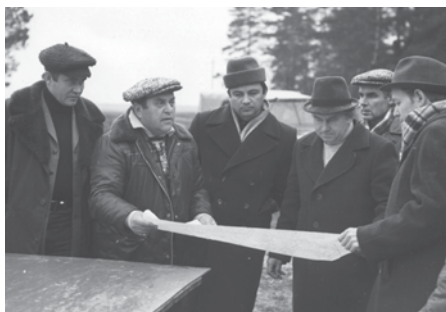
Ю.Е. Седаков на строительстве ОЦ Сержа
