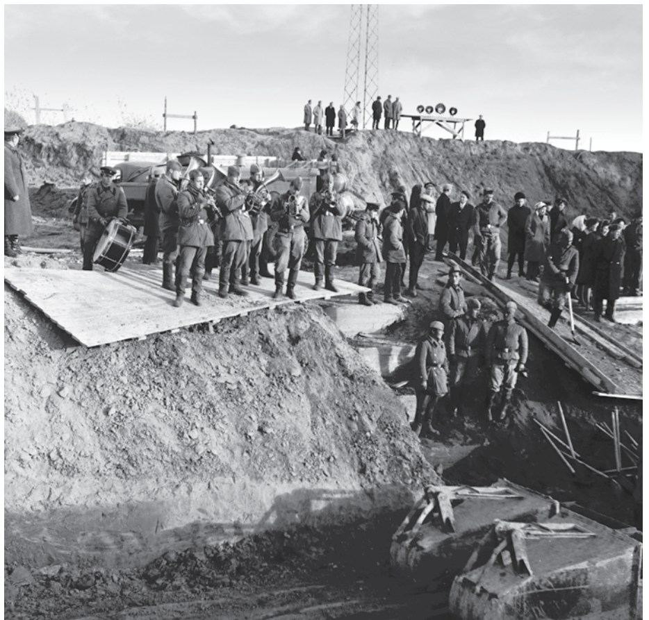
Торжественная закладка фундамента
