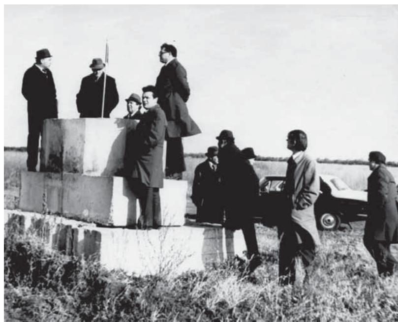
Закладка первого камня в фундамент будущей РоАЭС
