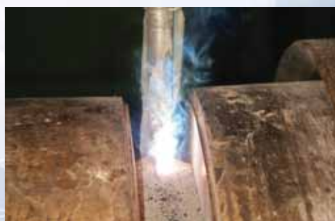
Сварка цанг для транспортно-упаковочного контейнера
