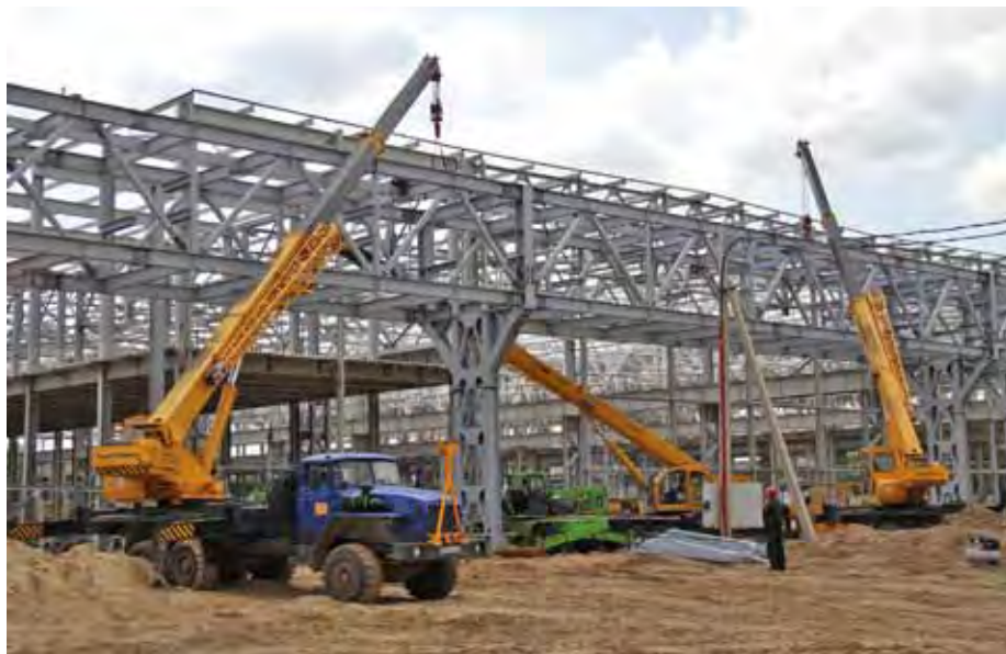
На строительной площадке нового машзавода, 2013 г.
