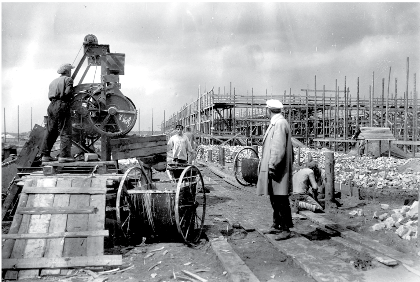
Новое Сормово строится
