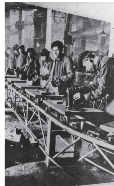
Сборка приемников патронных коробок
