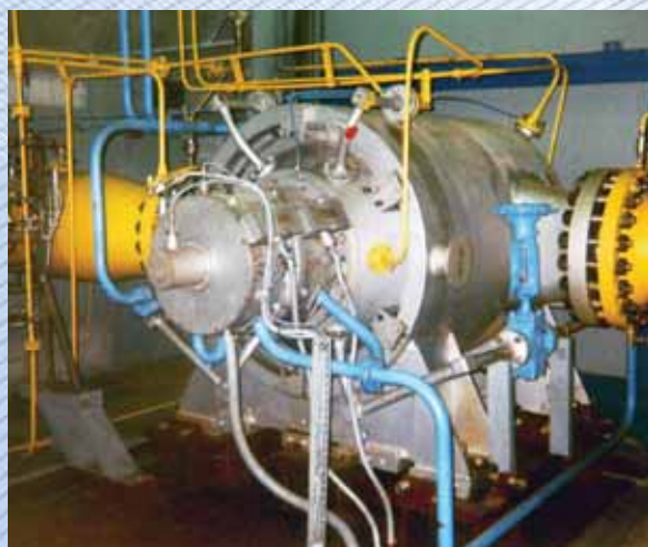
Нагнетатель NC-12-56/1,44 в составе GPA-12M «Урал» на КС «Пермская»
