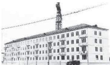
**Строительство первого в СССР крупнопанельного дома с применением технологии выпуска крупнопанельных бескаркасных домов, разработанной на заводе. Выкса, 1957 год**
