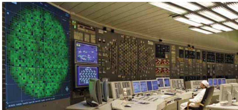
Курская АЭС сегодня. Блочный щит управления энергоблока № 2 после модернизации
