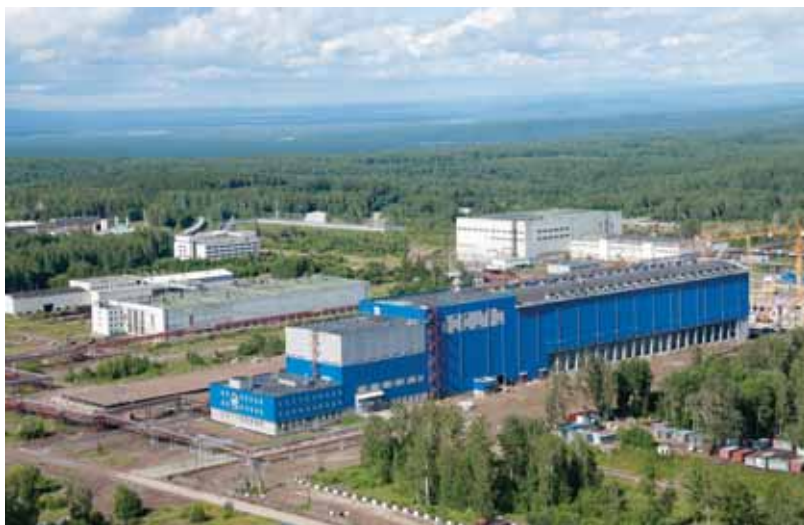
Пусковой комплекс сухого хранилища
