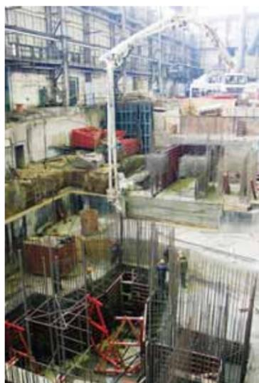
**Строительство нового пресса усилием 4000 тонн на месте радиально-ковочной машины, демонтаж которой также был уникальным процессом, успешно совмещается с выполнением производственной программы. Верхняя Салда**
