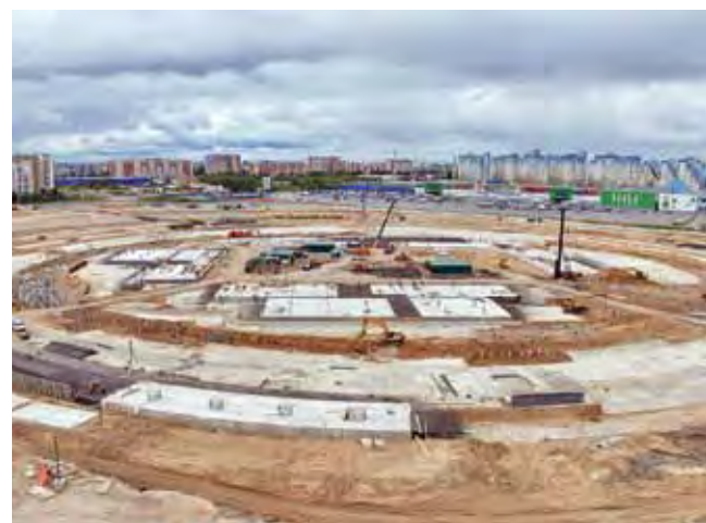
Строительство стадиона к ЧМ-2018
