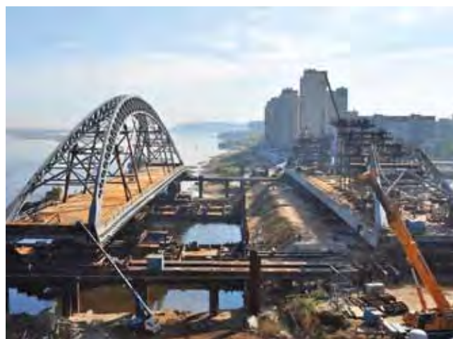
Строительство нового Борского моста
