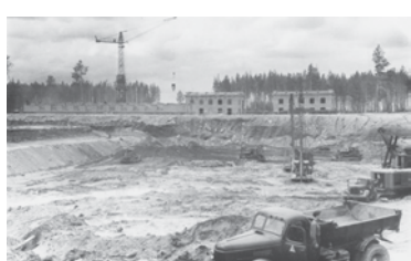
Котлован главного корпуса. 26.04.56 г.
