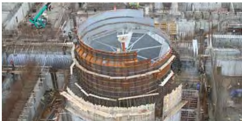
Монтаж шахты реактора БН-800
