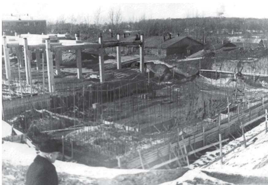
Строительство корпуса «А»
