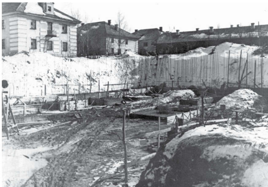
Строительство корпуса «Б»
