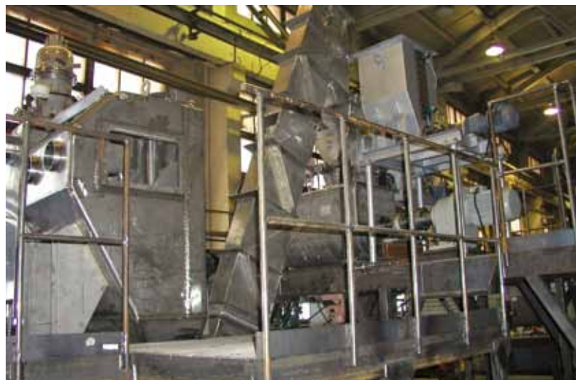
Узел загрузки установки сжигания РАО
