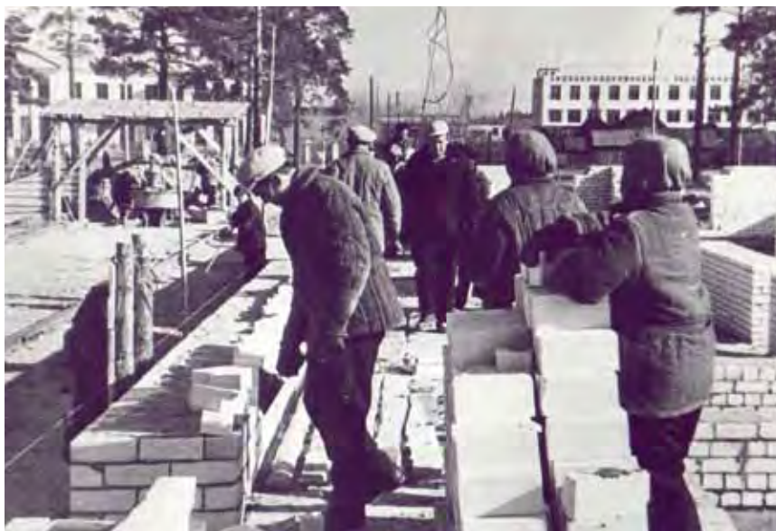
Строительство жилья для работников завода
